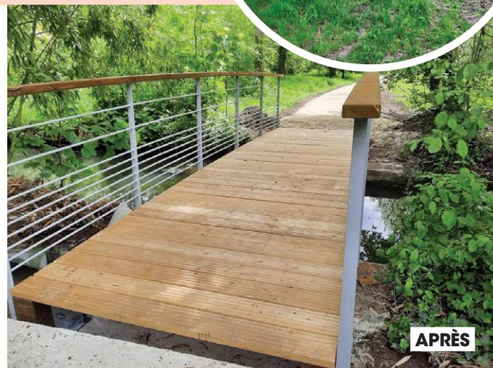
**FINALISÉ :** Passerelles : remplacement de deux passerelles en bois par deux neuves en robinier (bois local durable et résistant).
