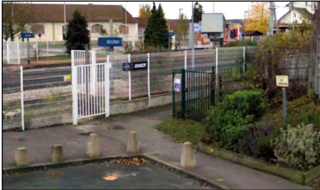
Passage sous la voie ferrée au niveau de la gare de Bouray Lardy
