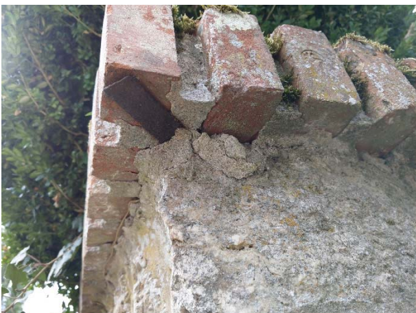
Détail du méplat métallique figé dans la maçonnerie pour soutenir la brique d'angle, dans une disposition d'origine, et dans un état dégradé.
