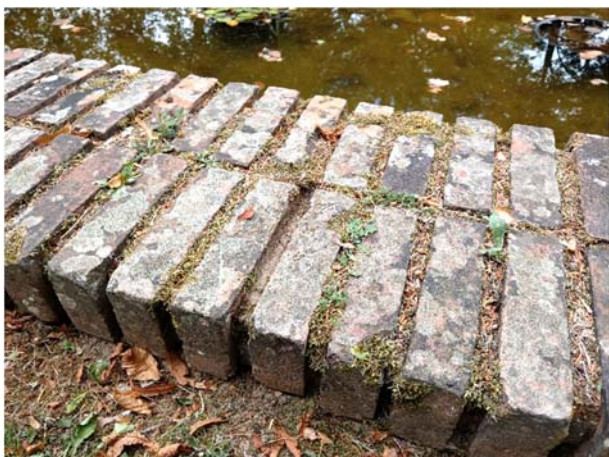
Briques posées à chant, joint filant qui se retourne dans les angles.
