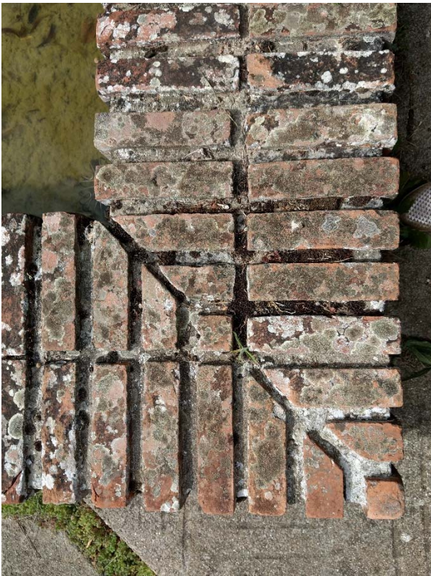
Détail du joint filant et de la coupe d'onglet sur les briques. Détail du sceau HS sur la boutisse (Briqueterie Henri Sachot)
