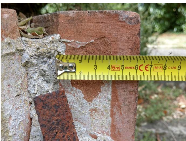
Détail du couronnement en briques sur les murets, sd, ca 1930, N°25, © CAPA/IFA
