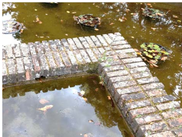
Briques posées à chant, joint filant qui se retourne dans les angles.
