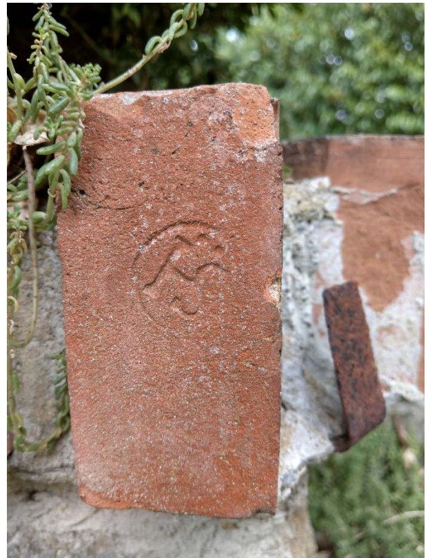
Détail du joint filant et de la coupe d'onglet sur les briques. Détail du sceau HS sur la boutisse (Briqueterie Henri Sachot)
