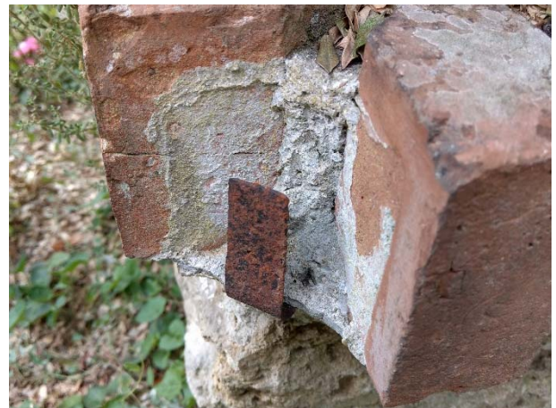
Détail du méplat métallique figé dans la maçonnerie pour soutenir la brique d'angle, dans une disposition d'origine, et dans un état dégradé.
