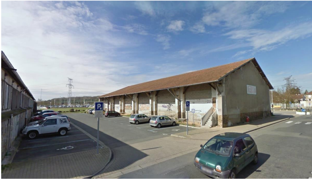
La halle sera requalifiée en pôle de vie et contribuera au dynamisme du site.
