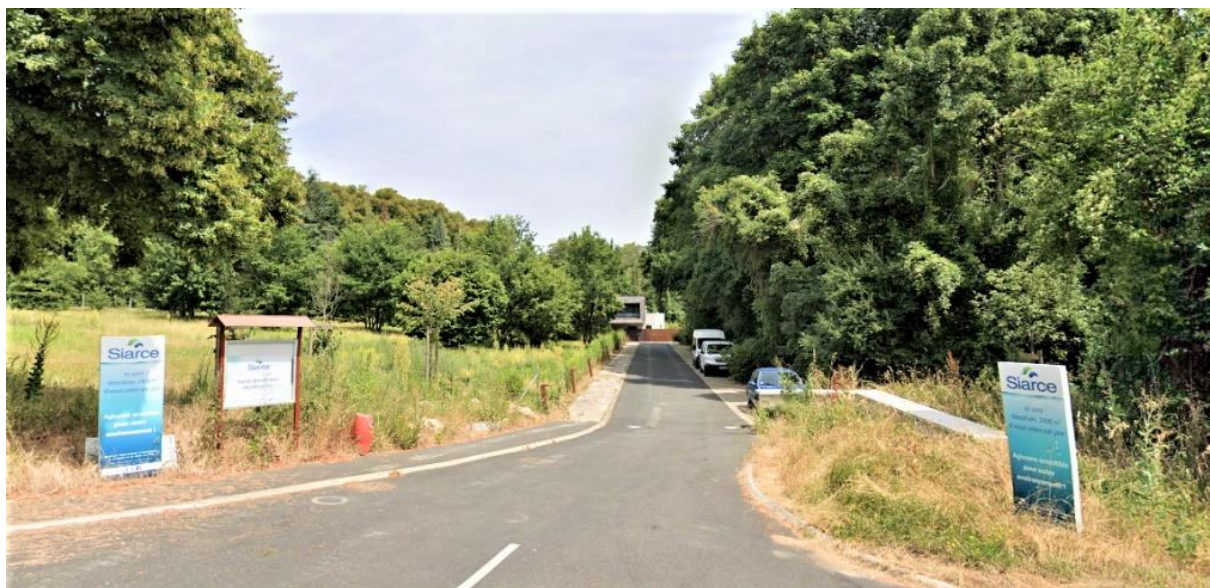
Entrée de la STEP de Saint-Vrain, Route Nationale (Source : 2AD)
